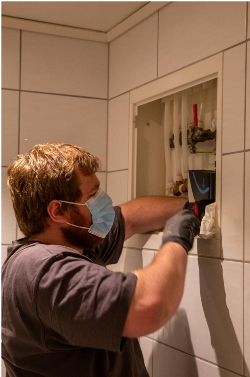
Ørjan Ullenes gjør kort prosess på installeringen av en ny vannmåler. Foto: Jo Henrik Jarstø
